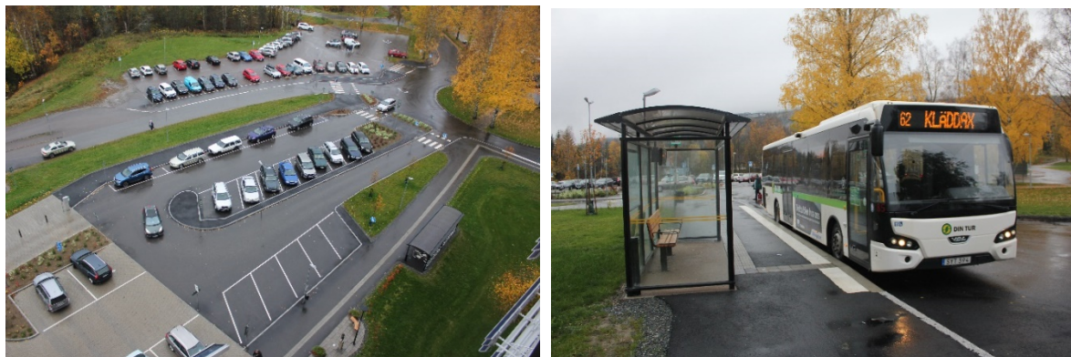
Bild 1: Ombyggd yttre miljö vid Sollefteå sjukhus. Bild 2: Ombyggd busshållplats Sollefteå sjukhus.
