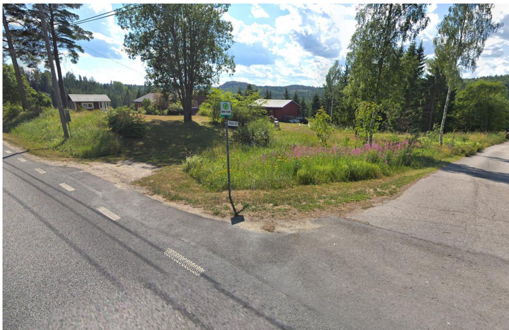
Figur 36. Exempel på enklare utformad hållplats i Västernorrland. Det finns ännu enklare utförda hållplatser som utgörs av så kallade "vinkhållplatser". De innebär att resenären vinkar till chauffören när denna vill resa med bussen.
