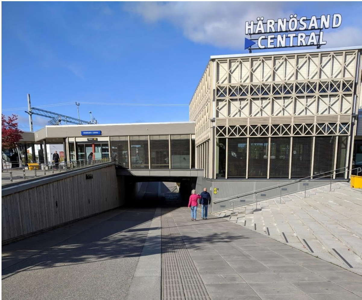
Figur 6. Gång- och cykelpassagens under Härnösands Central. Foto: Tyréns 2018.
