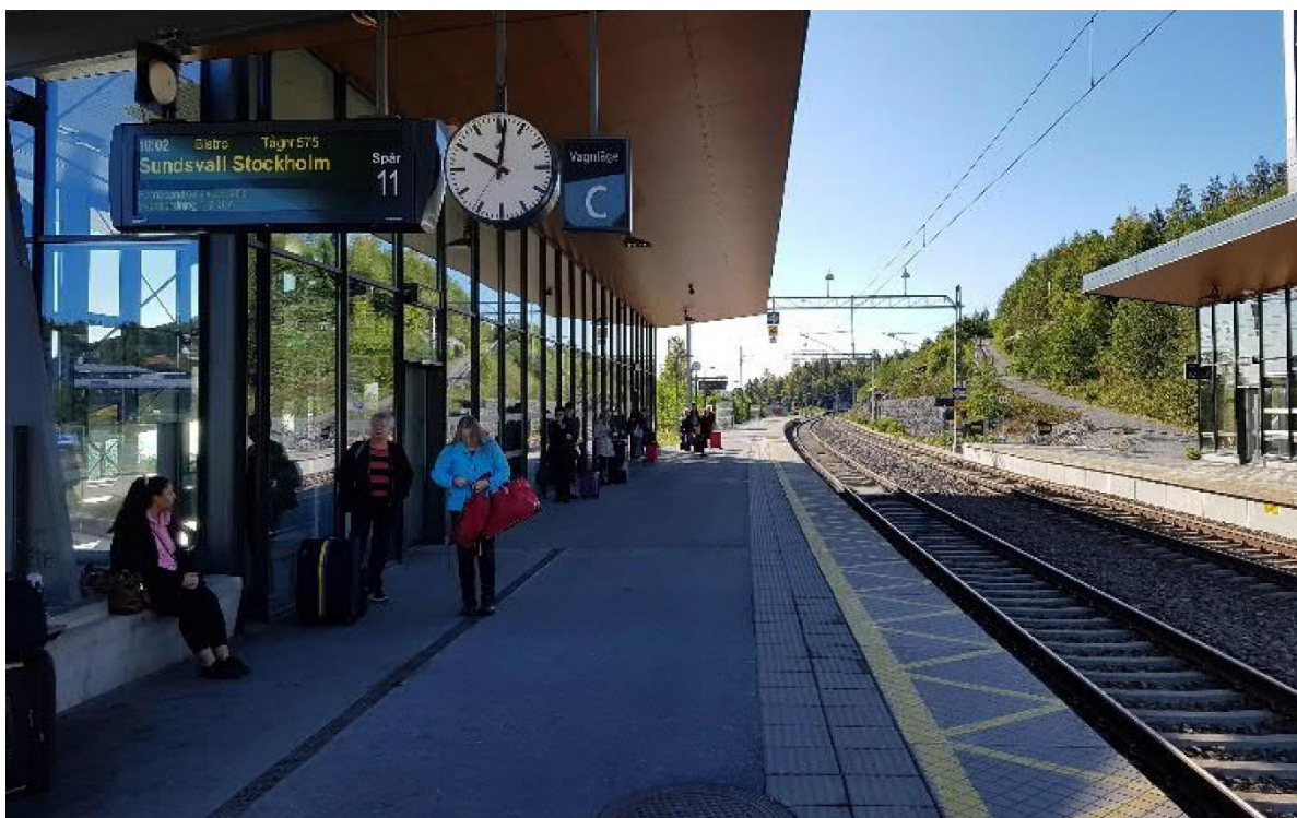
Figur 7. Plattformarna på Örnköldsviks Resecentrum. Foto: Tyréns 2018.
