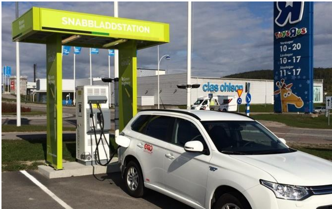
Figur 79. En laddstation för elbilar (bild: www.uppladdning.nu )
