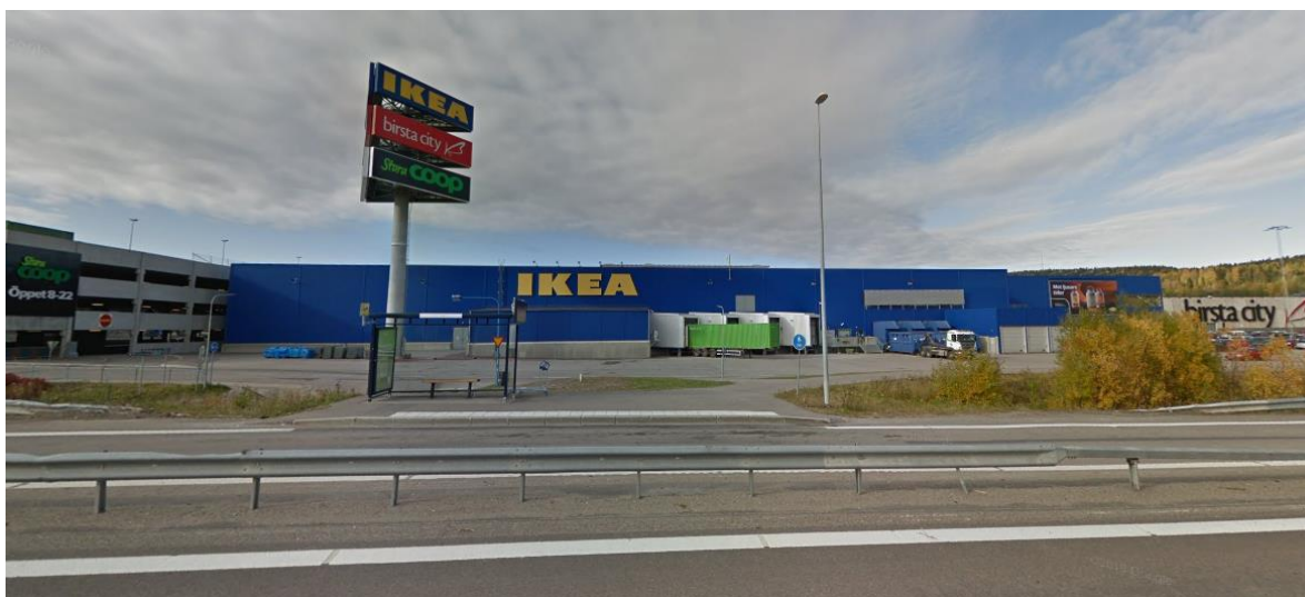
Figur 30. Birsta E4 hållplats mot Sundsvall (bild: Google)
