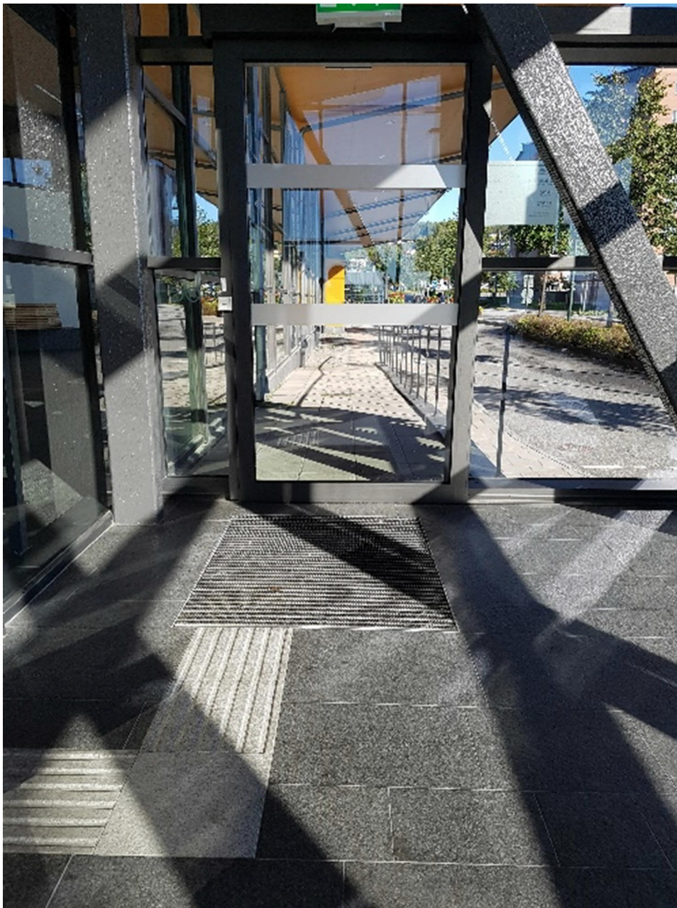
Bild 43. Skrapgaller avbryter ledstråk.
