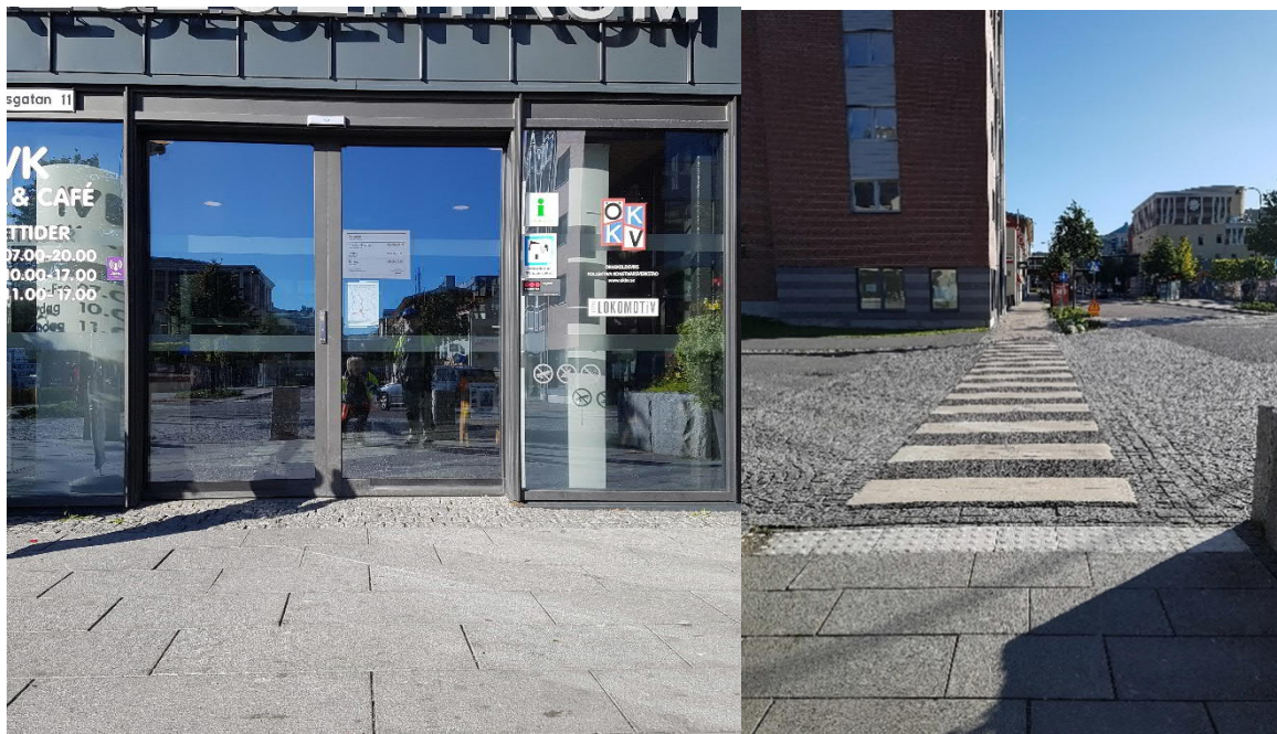
Bild 33. Stationshusets entré utan taktila stråk (vänster) övergångsställe utan taktila stråk (höger).
