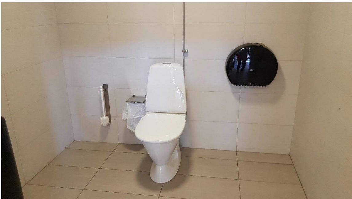
Bild 12. Hygienrum för rörelsehindrade som saknar kontraster samt armstöd till toalettstol.
