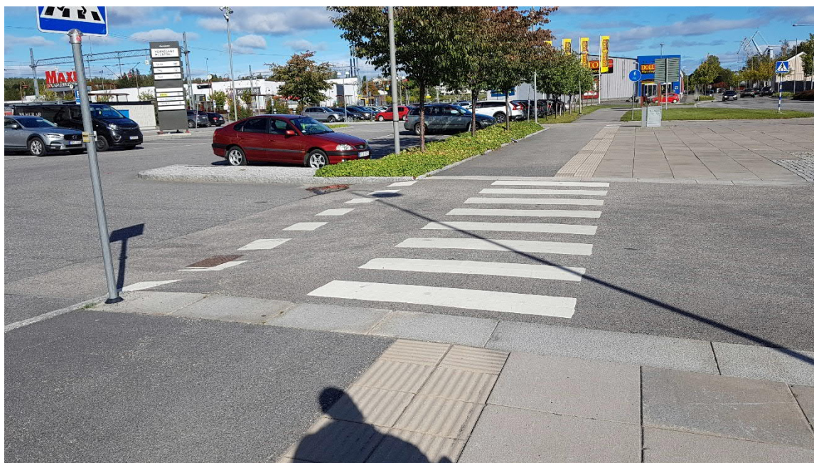
Bild 5. Felvända sinusplattor istället för kupolplattor vid övergångsställe.
