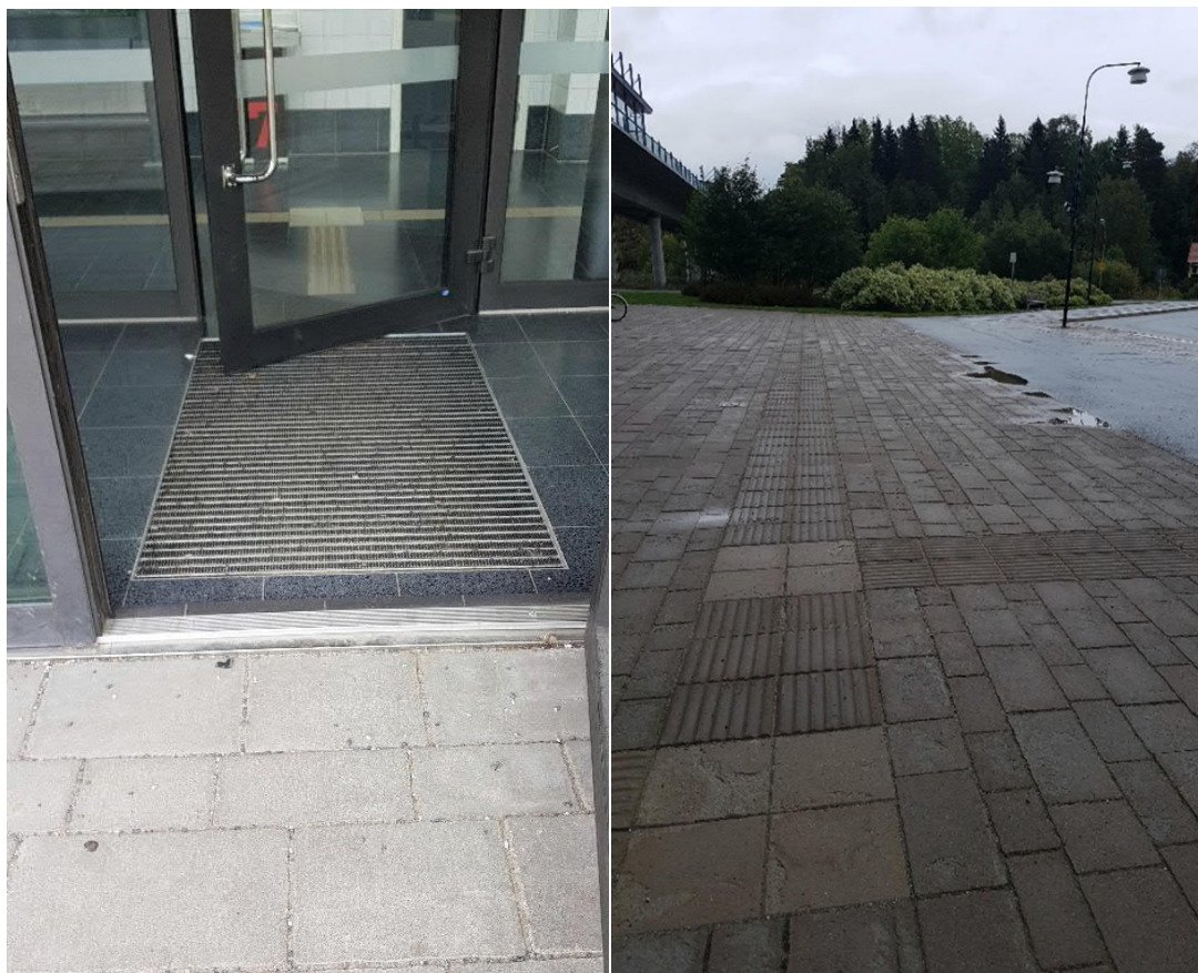
Bild 46. Entré till resecentret (vänster) ledyta med dålig kontrast (höger).
