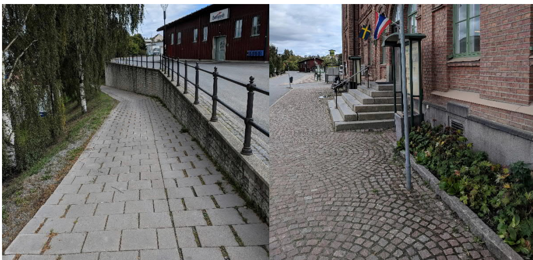
Bild 21. Ramp med ojämn beläggning (vänster) och entré mot stationshus (höger).
