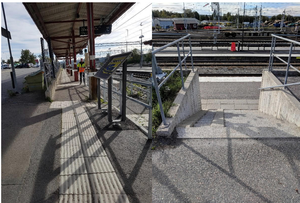
Bild 25. Taktill orienteringskarta (vänster) trappa utan kontrast-/taktila markeringar (höger).
